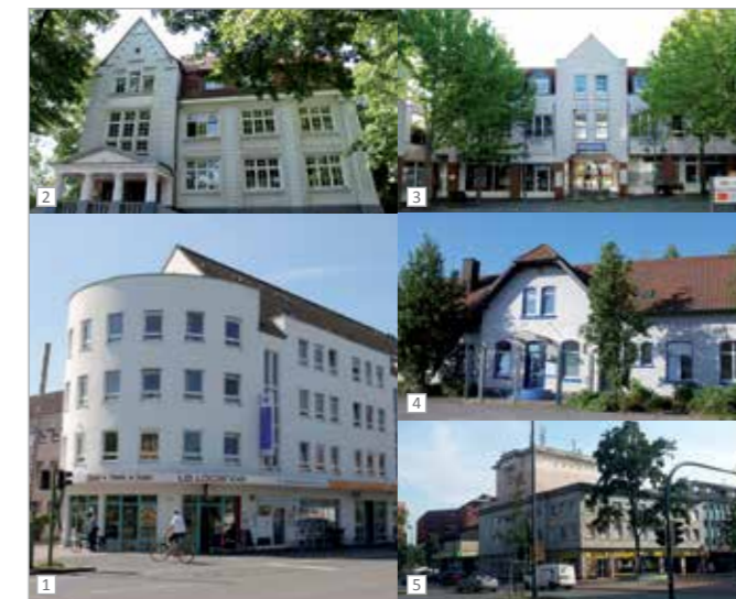
1: Lünen · 2: Lünen-Süd · 3: Bergkamen · 4: Hamm · 5: Hamm
